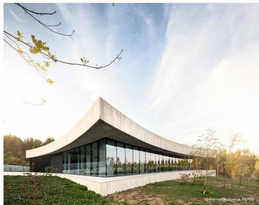
CASA CABO DE VILA Paredes, PORTUGAL Arq: spaceworkers®
